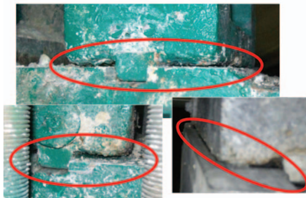
Figura 14. Observe el espacio y la poca área de contacto entre los bloques removibles y el bastidor. Esto reduce drásticamente la estabilidad de la pieza que se soporta en estas uniones y se pueden producir vibraciones o movimientos durante el funcionamiento.
