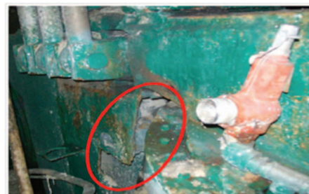
Figura 9. Existe corrosión en la parte exterior e inferior de esta viga principal del lado conductor y presenta evidentes señales de delaminado que ha sido reparado retirando el material suelto y pintando nuevamente. Sin embargo, la pérdida de espesor es mínima.
