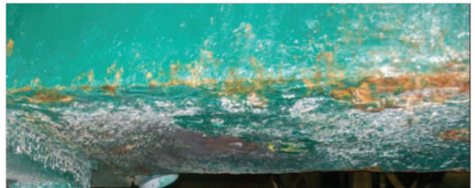
Figura 9. Existe corrosión en la parte exterior e inferior de esta viga principal del lado conductor y presenta evidentes señales de delaminado que ha sido reparado retirando el material suelto y pintando nuevamente. Sin embargo, la pérdida de espesor es mínima.
