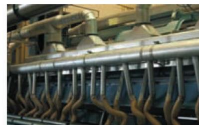
Figura 12. Los nuevos sistemas de control de polvo sobre y fuera de la hoja en PM1, han funcionado tanto para la satisfacción del personal de la fábrica, como para sus clientes.
