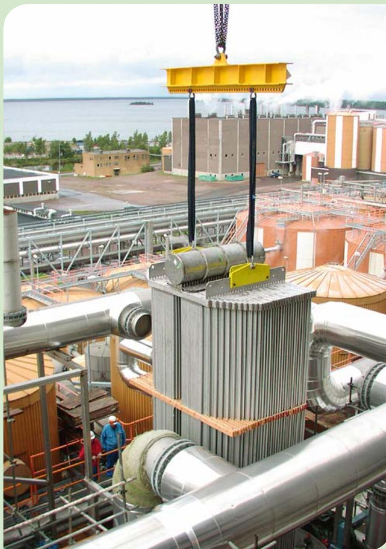
Em 2001, a Valmet substituiu lamelas danificadas com a instalação de superfície de troca térmica do tipo TUBEL na planta Cell Värö da Södra.
