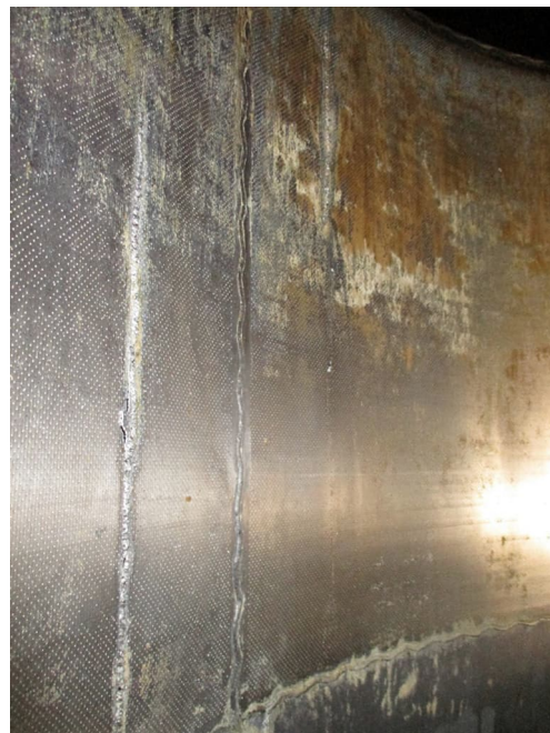
スクリーンプレートの溶接補修
