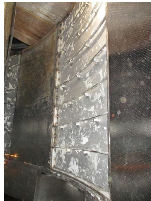
スクリーンプレートの張替え
